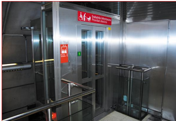
Figura 35: Salida ascensor interior frente a andenes
